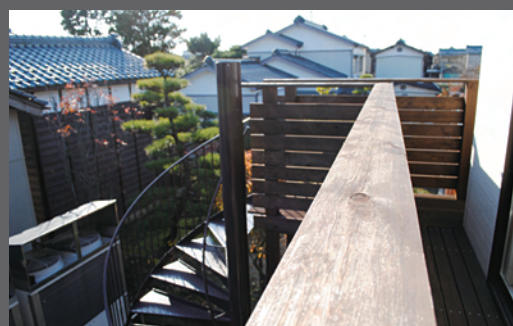
2階避難バルコニーから地上への避難階段
