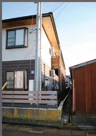
建物裏側に避難バルコニーが廻る
