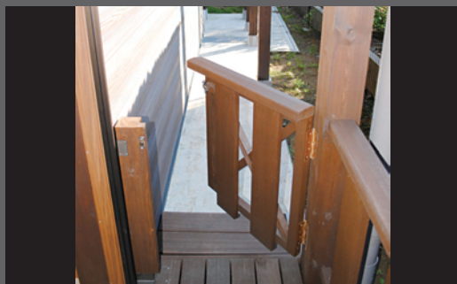
建物裏側1階の避難バルコニー出口付近の扉
