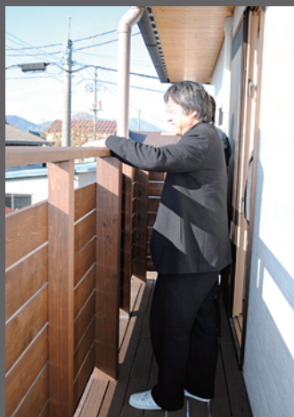
転落事故防止のため手摺は高め(h=1,300)
