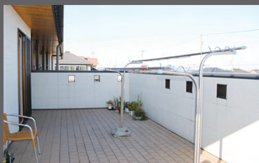
2階テラス：通常は指定された喫煙場所であり、火災時には2階居住者の一時待避場所ともなる
