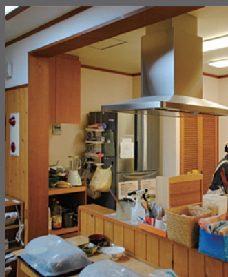
オープンな厨房のため廊下も火気使用室として扱う
