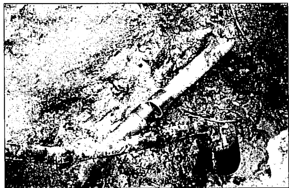
b) φ75 硬質塩化ビニル管 破損
